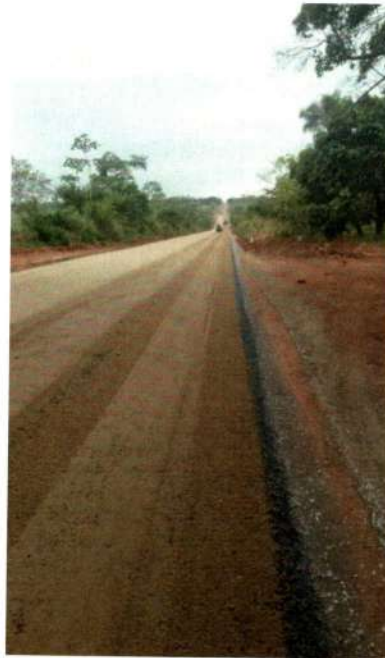
Serviço: Pavimentação Local: 15°35'18"S – 58°14'53"W
