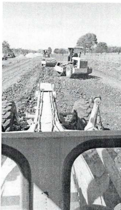
Serviço: Remoção de pavimento existente Localização: 15°35'10" S – 58°14'59" W
