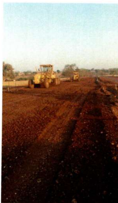
Serviço: Preparo para Reconfecção de Base Localização: 15°35'10" S – 58°14'59" W
