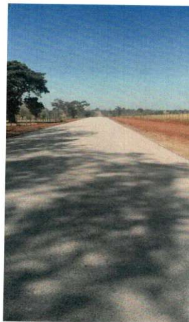
Serviço: Capa em TSD Local: 15°35'04"S – 58°14'59"W
