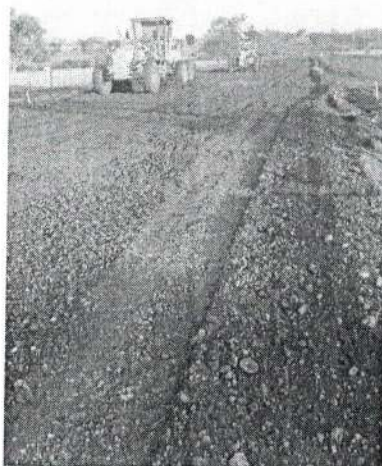
Serviço: Preparo para Reconfecção de Base Localização: 15°35'10" S – 58°14'59" W
