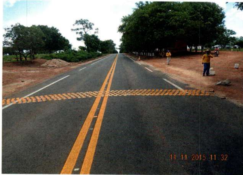
Serviço: Sinalização Horizontal Local: S 15° 33' 55" – W 58° 15' 32"
