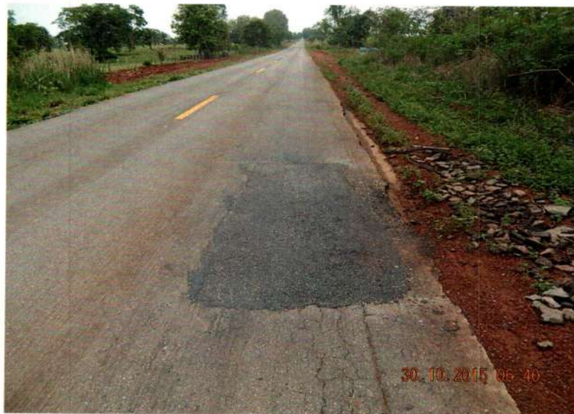
Serviço: Tapa-Buracos Local: S 15° 33' 0" – W 58° 15,54' 8"
