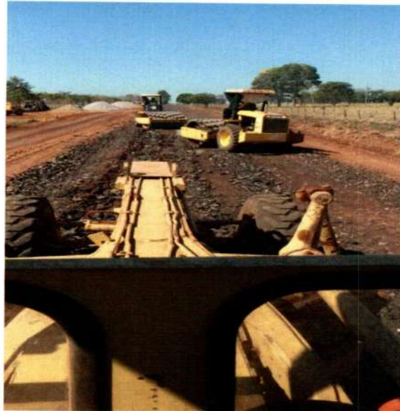
Serviço: Remoção do Pavimento Existente Localização: S 15° 35' 10" – W 58° 14' 59"
