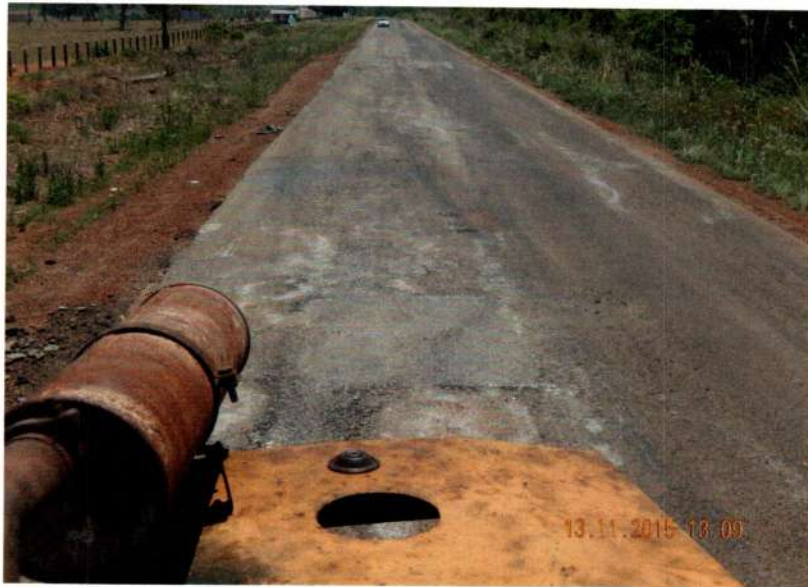
Serviço: Tapa-Buracos Local: S 15° 48' 37" - W 58° 5' 8"
