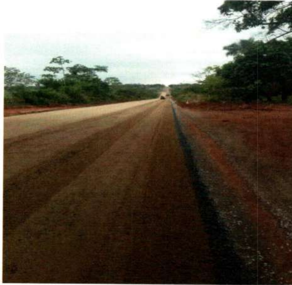
Serviço: Pavimentação Local: S 15° 35' 18" – W 58° 14' 53"
