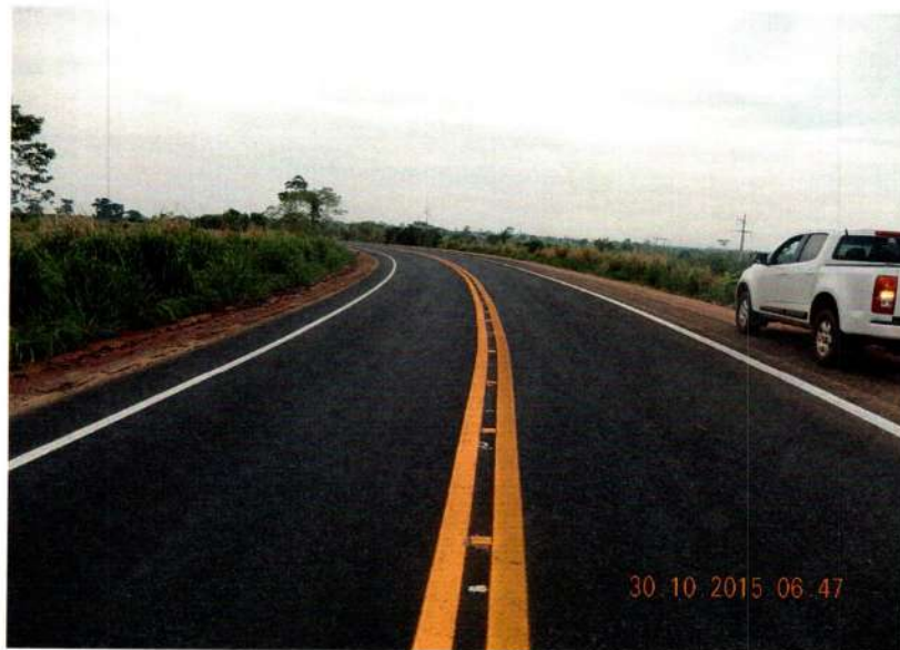
Serviço: Sinalização Horizontal Local: S 15° 30' 34" - W 58° 16' 58"
