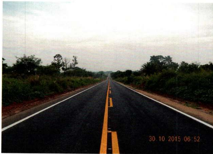
Serviço: Sinalização Horizontal Local: S 15° 29' 56,5" – W 58° 18' 16,8"
