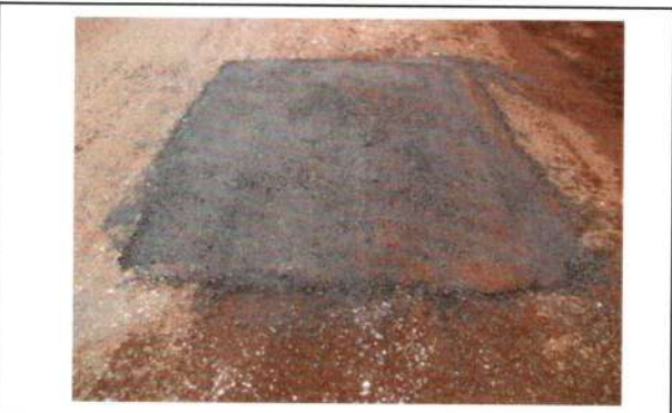
Coordenada: Localização: Serviço: MT - 175 TAPA - BURACO
