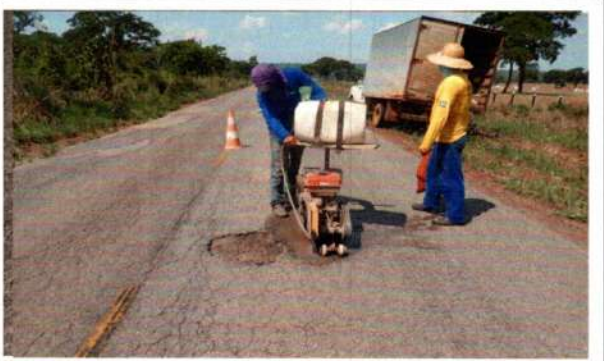
Coordenada: Localização: Serviço: MT - 175 TAPA-BURACO
