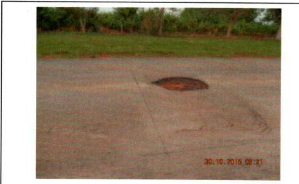
Coordenada: Localização: Serviço: MT - 175 TAPA-BURACO
