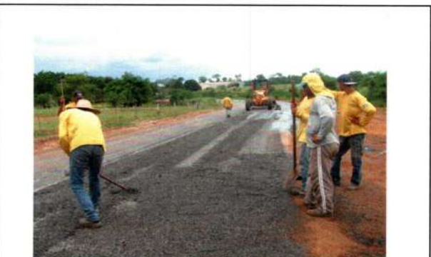
Coordenada: Localização: Serviço: MT - 175 PMF FRESAGEM
