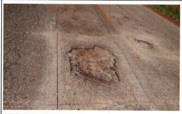
Coordenada: Localização: Serviço: MT - 175 TAPA-BURACO
