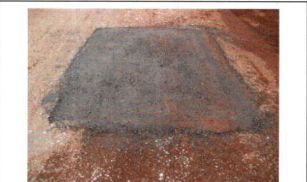
Coordenada: Localização: Serviço: MT - 175 TAPA-BURACO
