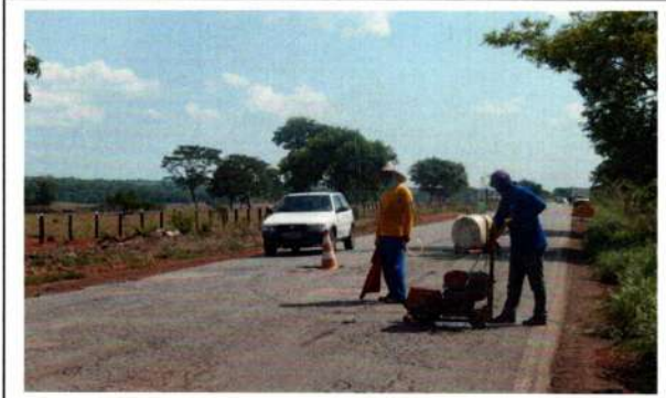
Coordenada: Localização: Serviço: MT - 175 TAPA-BURACO
