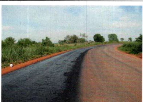
Coordenada: Localização: Serviço: MT - 175 PINTURA DE LIGAÇÃO
