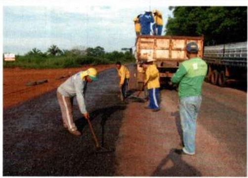
Coordenada: Localização: Serviço: MT - 175 TAPA-BURACO
