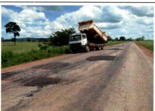
Coordenada: Localização: Serviço: MT - 175 TAPA-BURACO
