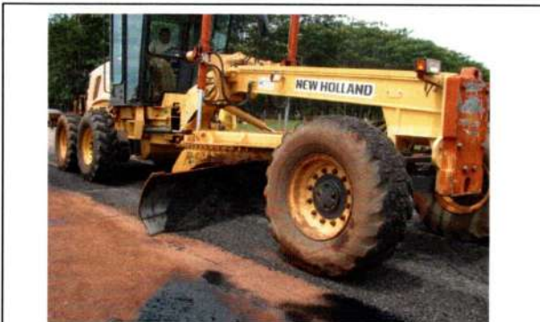
Coordenada: Localização: Serviço: MT - 175 PMF FRESAGEM
