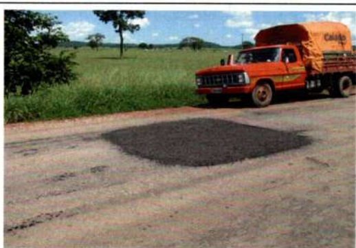
Coordenada: Localização: Serviço: MT - 175 TAPA-BURACO
