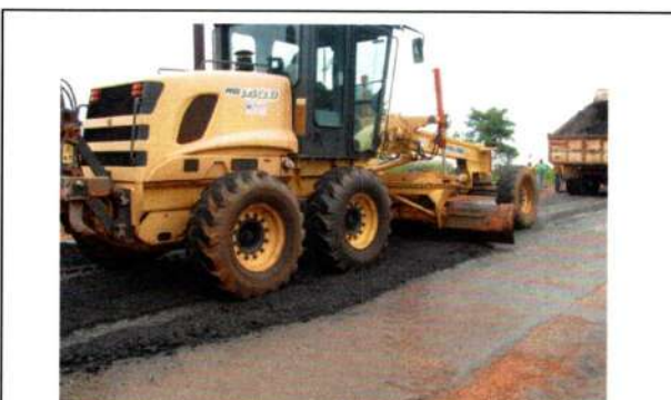
Coordenada: Localização: Serviço: MT - 175 PMF FRESAGEM
