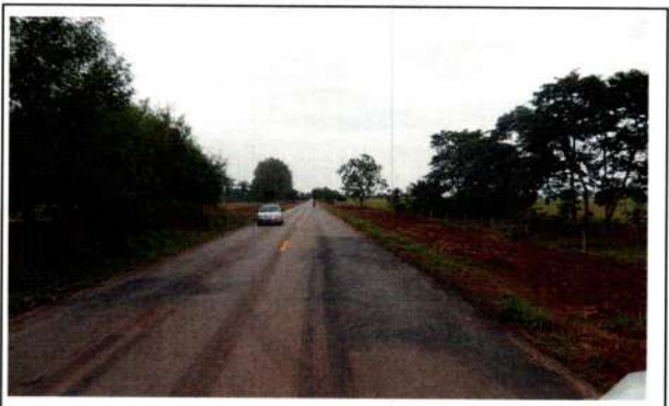
Coordenada: Localização: Serviço: MT - 175 TAPA - BURACO
