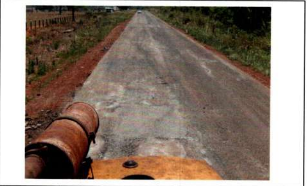
Coordenada: Localização: Serviço: MT - 175 TAPA - BURACO
