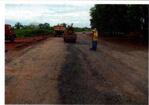
Coordenada: Localização: Serviço: MT - 175 TAPA-BURACO
