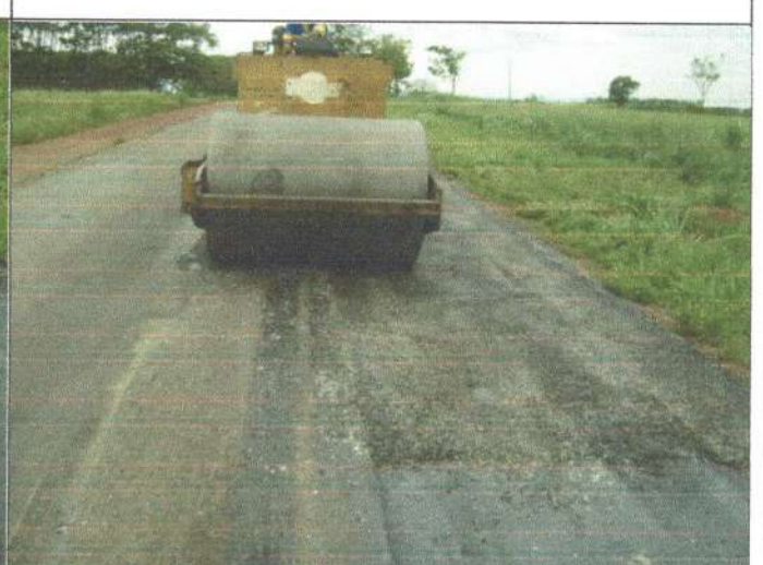
SERVIÇO: TAPA BURACO COORDENADAS: 15°46'58,6"S 58°06'06,5"W
