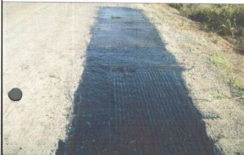
SERVIÇO: IMPRIMAÇÃO COORDENADAS: 15°46'52,9"S 58°06'10,2"W
