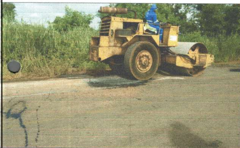
SERVIÇO: CBUQ COORDENADAS: 15°46'58,6"S 58°06'06,5"W
