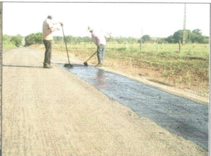
SERVIÇO: PINTURA DE LIGAÇÃO COORDENADAS: 15°46'52,9"S 58°06'10,2"W
