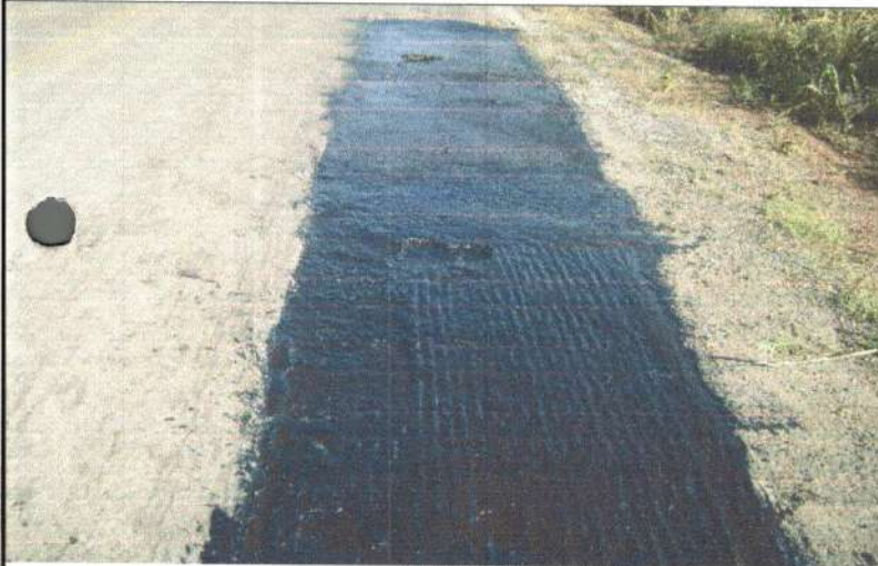
SERVIÇO: IMPRIMAÇÃO COORDENADAS: 15°46'52,9"S 58°06'10,2"W
