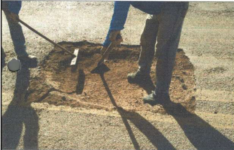
SERVIÇO: TAPA BURACO COORDENADAS: 15°46'58,6"S 58°06'06,5"W
