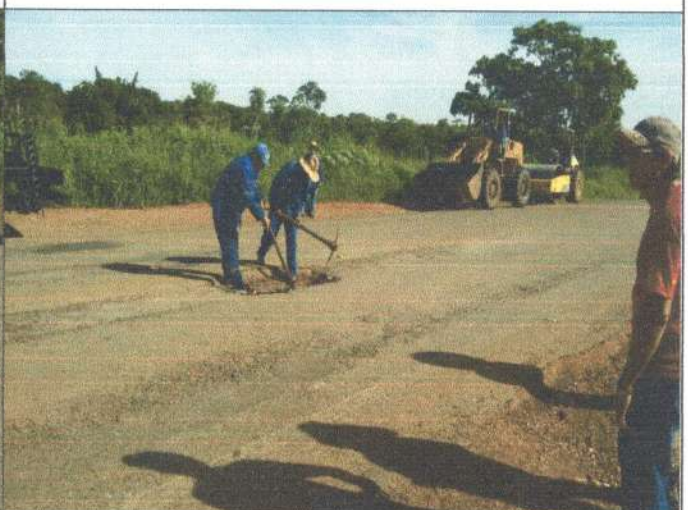
SERVIÇO: TAPA BURACO COORDENADAS: 15°46'52,9"S 58°06'10,2"W
