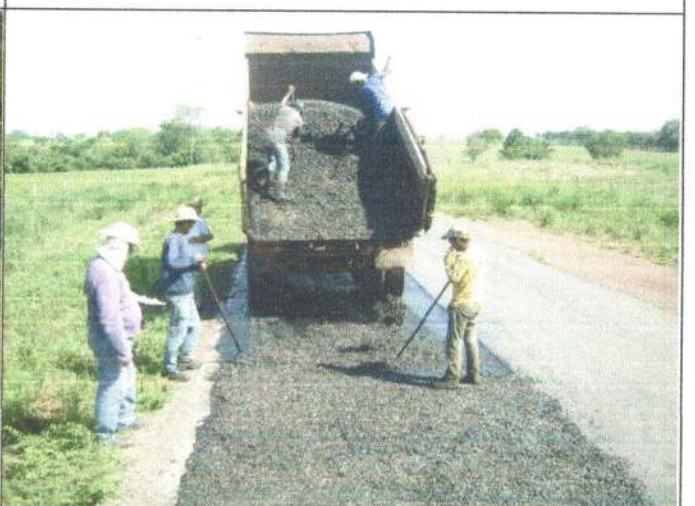
SERVIÇO: PRÉ-MISTURADO A FRIO - PMF COORDENADAS: 15°46'52,9"S 58°06'10,2"W
