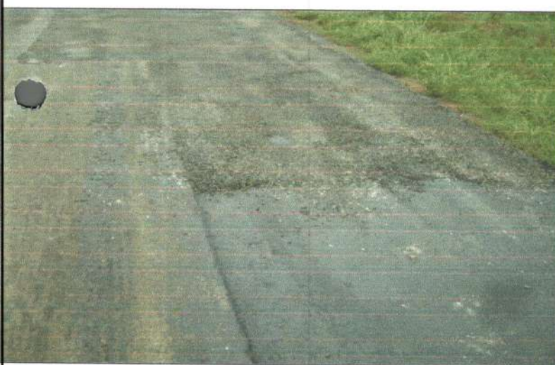
SERVIÇO: TAPA BURACO COORDENADAS: 15°46'58,6"S 58°06'06,5"W
