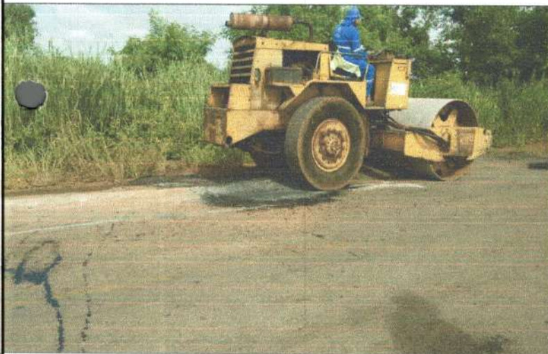
SERVIÇO: CBUQ COORDENADAS: 15°46'58,6"S 58°06'06,5"W
