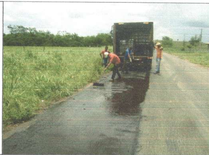
SERVIÇO: PINTURA DE LIGAÇÃO COORDENADAS: 15°46'58,6"S 58°06'06,5"W
