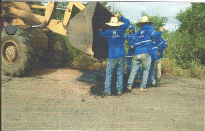
SERVIÇO: CBUQ COORDENADAS: 15°46'58,6"S 58°06'06,5"W
