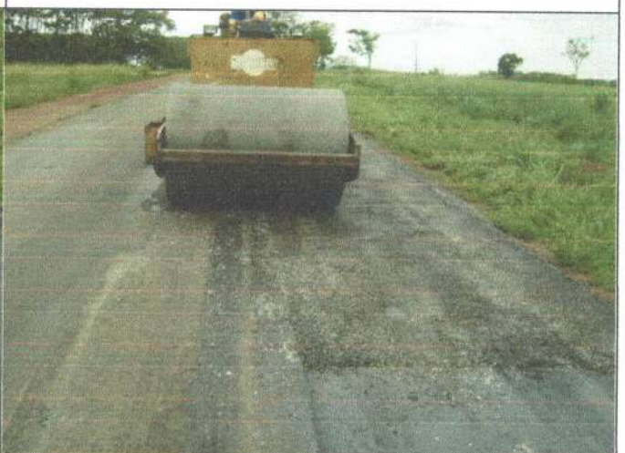
SERVIÇO: TAPA BURACO COORDENADAS: 15°46'58,6"S 58°06'06,5"W
