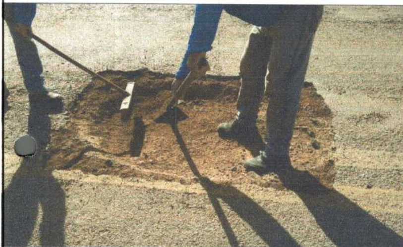
SERVIÇO: TAPA BURACO COORDENADAS: 15°46'58,6"S 58°06'06,5"W
