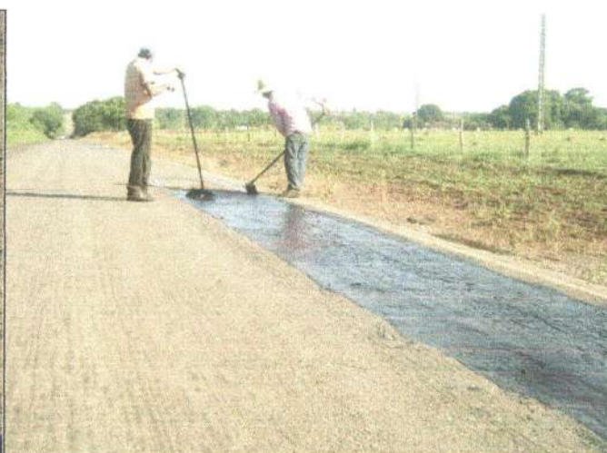
SERVIÇO: PINTURA DE LIGAÇÃO COORDENADAS: 15°46'52,9"S 58°06'10,2"W
