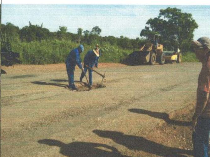
SERVIÇO: TAPA BURACO COORDENADAS: 15°46'52,9"S 58°06'10,2"W
