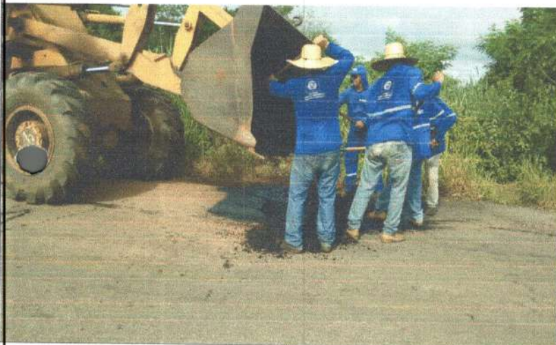
SERVIÇO: CBUQ COORDENADAS: 15°46'58,6"S 58°06'06,5"W
