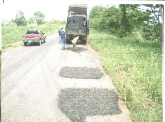
SERVIÇO: TAPA BURACO COORDENADAS: 15°46'58,6"S 58°06'06,5"W
