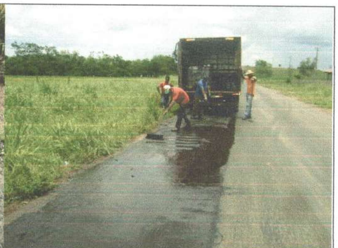
SERVIÇO: PINTURA DE LIGAÇÃO COORDENADAS: 15°46'58,6"S 58°06'06,5"W
