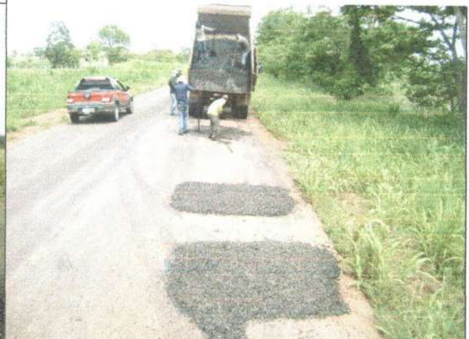
SERVIÇO: TAPA BURACO COORDENADAS: 15°46'58,6"S 58°06'06,5"W
