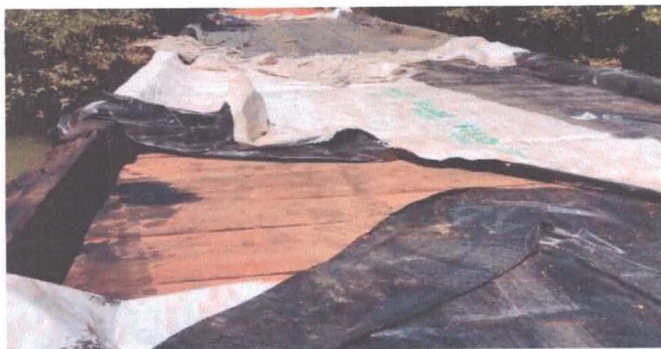
Foto: cobertura com a colocação da lona (impermeabilização) da ponte sem o rodado.
