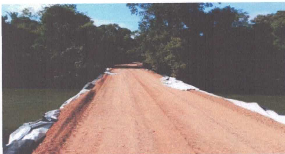
Foto: ponte coberta, guarda roda nivelado com terra/cascalho.
