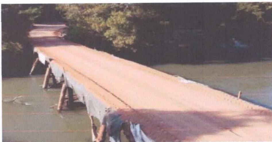
Foto: extensão da ponte com a terra/cascalho.
