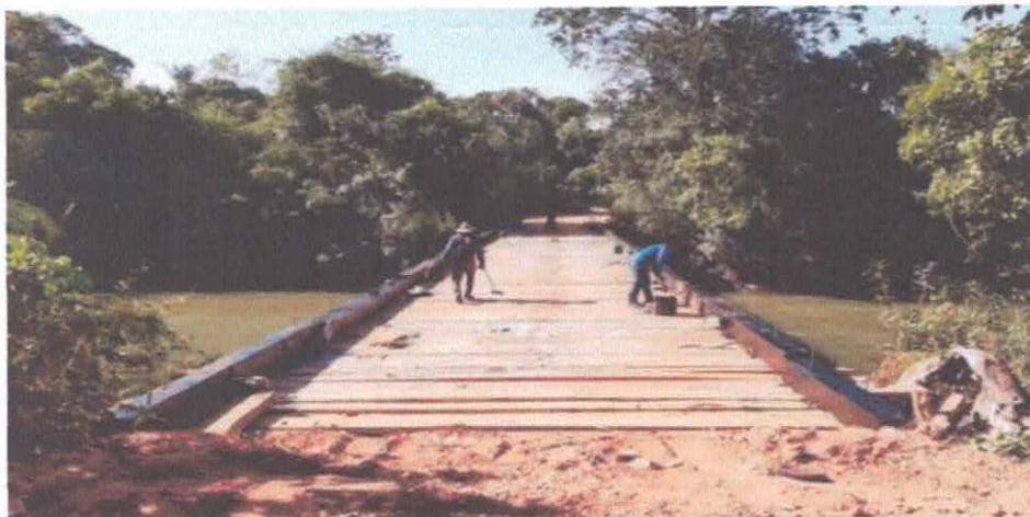
Foto: guarda roda nas laterais sem colocação do rodado no centro.
