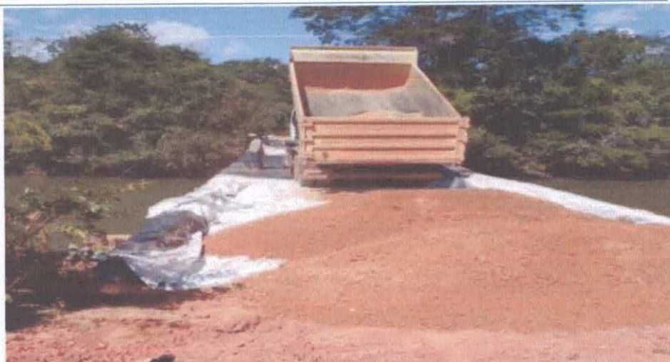
Foto: cobertura da ponte com cargas de terra/cascalho sobre a lona.
