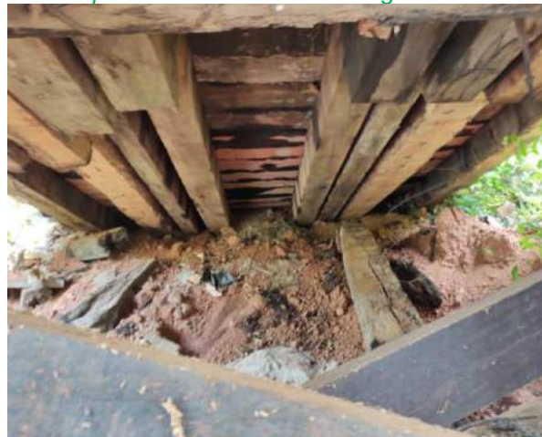
Ponte após a reforma com oito longarinas.
