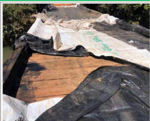
Foto registrada por um morador, momento antes dos caminhões da prefeitura de Tapurah aterra a ponte, verifica que não foi construído nenhum rodado na ponte.
