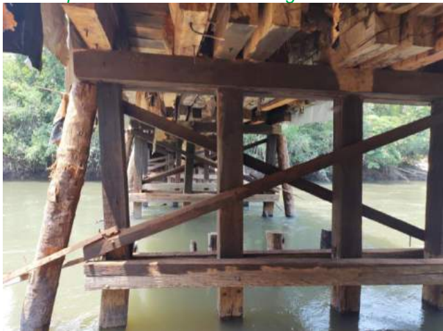
Ponte após a reforma com oito longarinas
