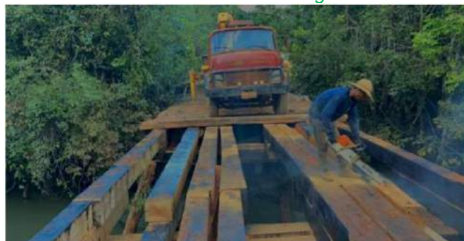
Ponte durante a reforma com duas longarinas a mais.
