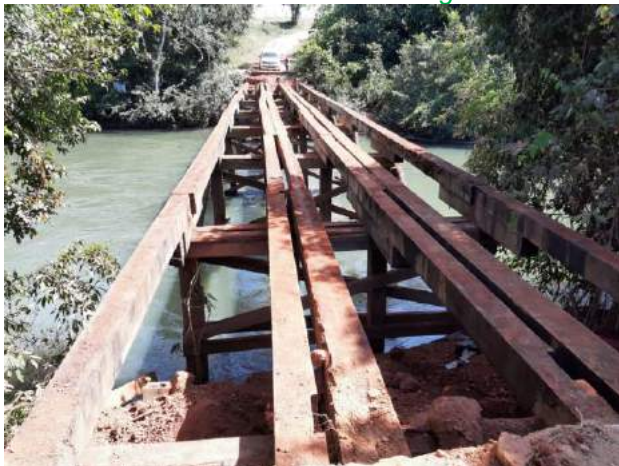
Ponte antes da reforma com seis longarinas
