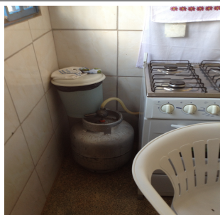
Botijão dentro do ambiente e lixo localizado em lugar inadequado
