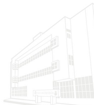
Edifício Marechal Rondon - Sede atual 2013
