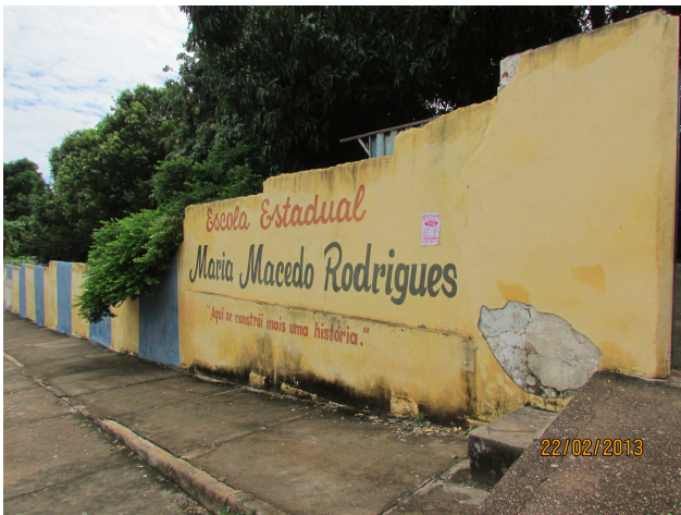
Muro, calçada de entrada da escola
