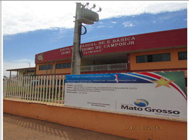
Rede Elétrica instalada.
