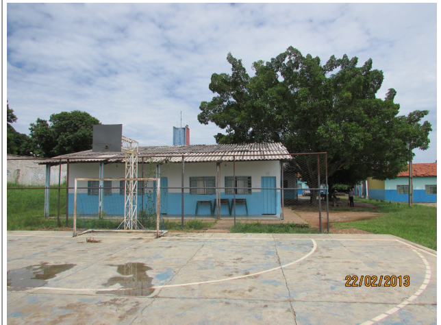
Quadra de Esportes – ainda descoberta. Duas salas que deveriam ser laboratório – estão desativadas.
