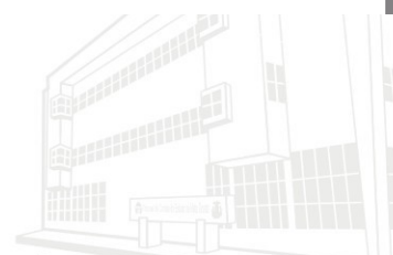
Edifício Marechal Rondon - Sede atual 2013
