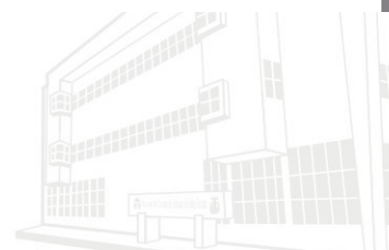
Edifício Marechal Rondon - Sede atual 2013
